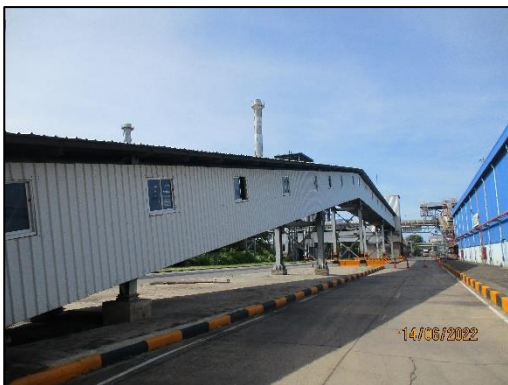
ภาพที่ 2.10 ระบบสายพานลำเลียงเชื้อเพลิงเข้าสู่ห้องเผาไหม้แบบปิด
