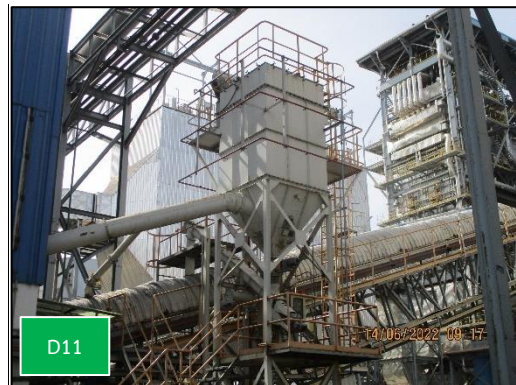
ภาพที่ 2.3 การติดตั้งระบบดักฝุ่นแบบถุงกรอง (ต่อ)
