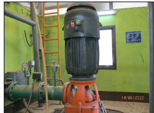
ภาพที่ 2.19 เครื่องสูบน้ำสำหรับสูบน้ำบาดาลในพื้นที่โครงการ
