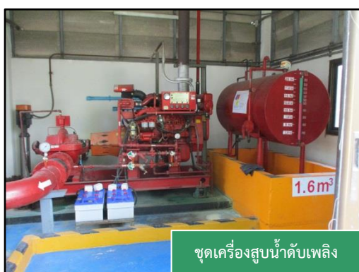
ภาพที่ 2.41 ระบบดับเพลิงภายในโครงการ (ต่อ)
