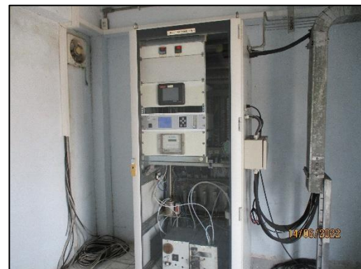
ภาพที่ 2.4 เครื่องตรวจวัดคุณภาพอากาศแบบต่อเนื่อง (CEMs)
