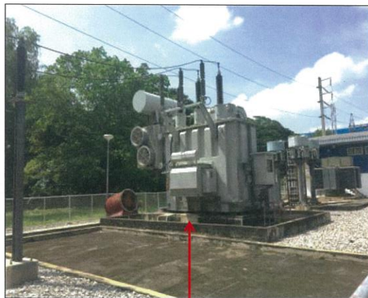
คันคอนกรีตรอบรับน้ำมันและน้ำฝนปนเปื้อน
