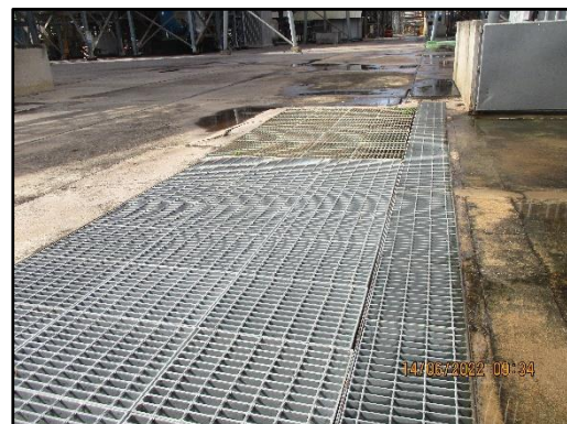
ภาพที่ 2.28 รางระบายน้ำฝนภายในพื้นที่โครงการ
