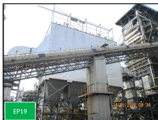
ภาพที่ 2.1 การติดตั้งระบบดักฝุ่นแบบไฟฟ้าสถิตย์ (ESP)
