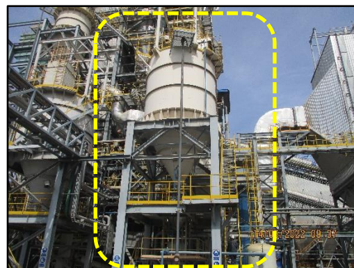
ภาพที่ 2.2 ระบบเติมหินปูนเข้าสู่หม้อไอน้ำ
