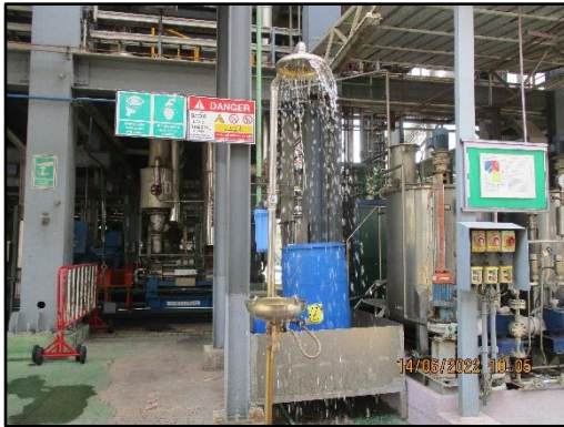
ภาพที่ 2.48 อ่างล้างตา และฝักบัวภายในพื้นที่โครงการ
