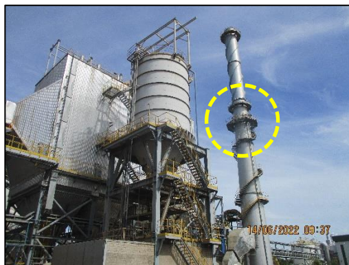
ภาพที่ 2.4 เครื่องตรวจวัดคุณภาพอากาศแบบต่อเนื่อง (CEMs)
