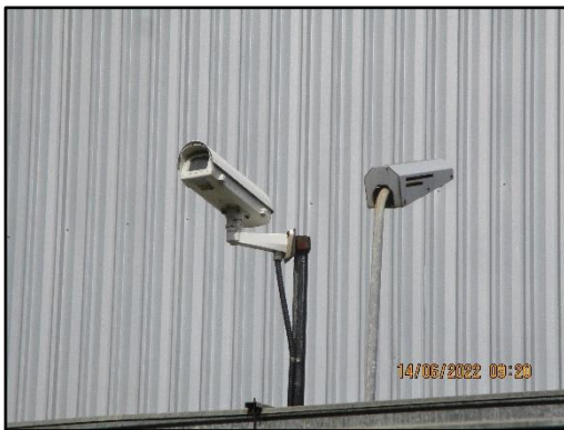
ภาพที่ 2.49 กล้องวงจรปิด (CCTV) และกล้องอินฟราเรด (Infrared camera)
