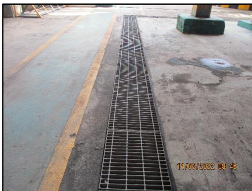
ภาพที่ 2.28 รางระบายน้ำฝนภายในพื้นที่โครงการ
