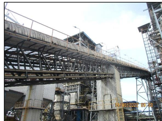
ภาพที่ 2.10 ระบบสายพานลำเลียงเชื้อเพลิงเข้าสู่ห้องเผาไหม้แบบปิด
