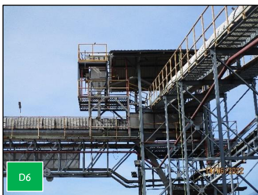
ภาพที่ 2.3 การติดตั้งระบบดักฝุ่นแบบถุงกรอง
