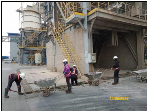
ภาพที่ 2.30 การขุดลอกตะกอนในรางระบายน้ำ
