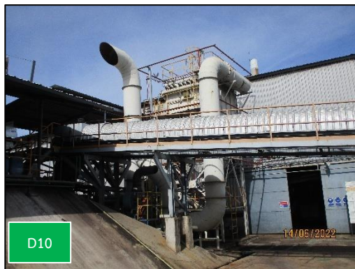
ภาพที่ 2.3 การติดตั้งระบบดักฝุ่นแบบถุงกรอง (ต่อ)
