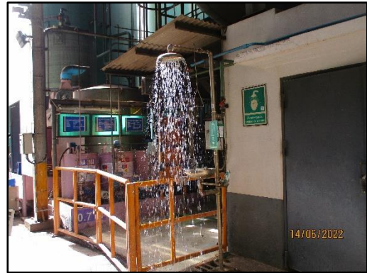
ภาพที่ 2.48 อ่างล้างตา และฝักบัวภายในพื้นที่โครงการ
